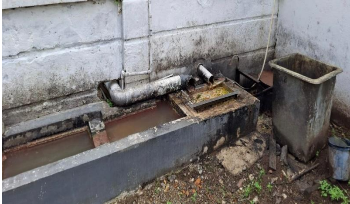
Gambar 1.1 contoh bak penangkap minyak dan lemak (konstruksi di luar dapur)
