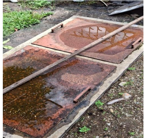
Gambar 1.1 contoh bak penangkap minyak dan lemak (konstruksi di luar dapur)
