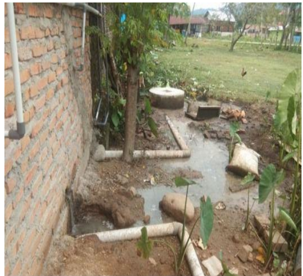
Gambar 2.2 contoh limbah padat dan limbah cair langsung di buang ke selokan
